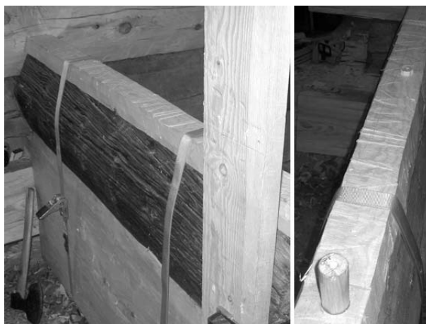
Eksempel på en gammel stok, hvor der er »sponset« et nyt stykke træ ind på toppen. Nederst til venstre i billedet står der en tømmerbile, som var den mest anvendte økse.
