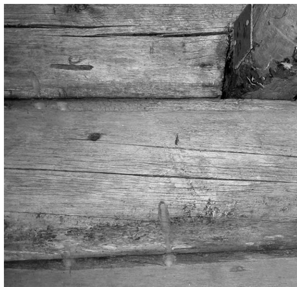
Kerneboringshuller stammer fra datering af stabburet.
