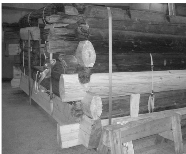
Arbejdet er nu så langt, at det er tydeligt at se, hvad der er blevet skiftet. Bemærk bundstokken (det midterste billede) under dørhullet – længden er ca. 5,5 m. og højden er henholdsvis 55 cm og 48 cm.
