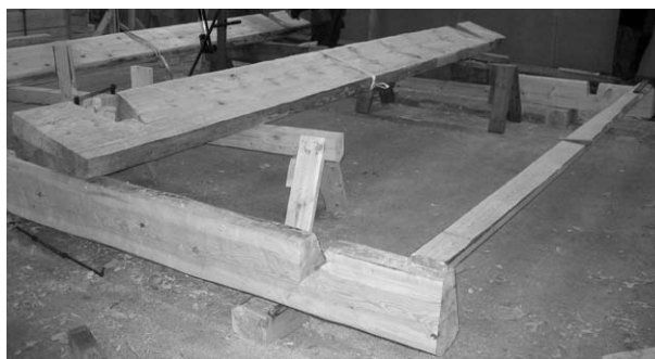
Bundstokken, som ligger på bukkene, har en længde på ca. 5,5 m, og højden er henholdsvis 55 cm og 48 cm.
